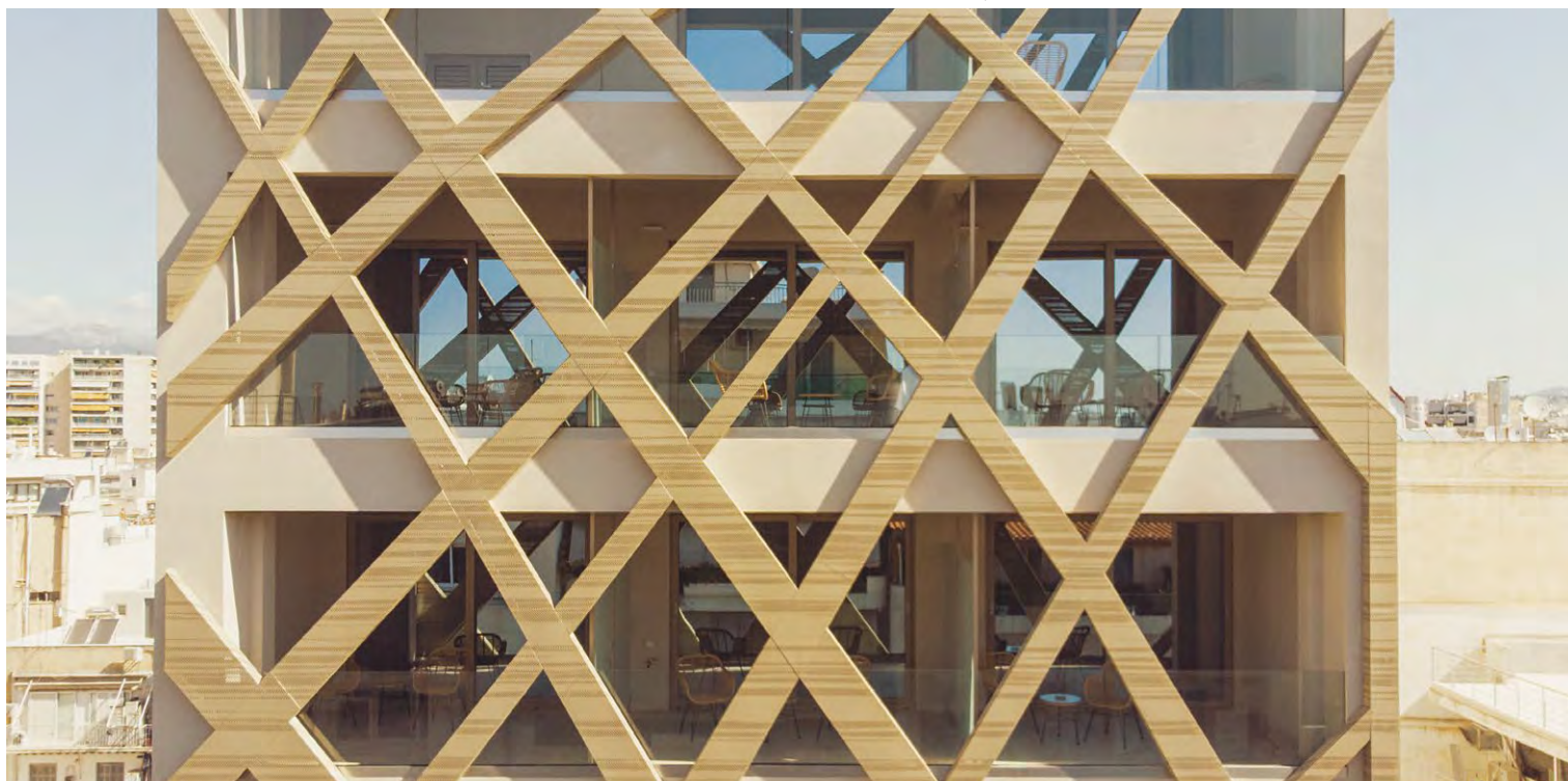
ΣΤΗΝ ΠΡΟΣΩΠΗ ΤΟΠΟΘΕΤΗΘΗΚΕ ΕΝΘΕΤΟ ΜΕΤΑΛΛΙΚΟ ΠΕΤΑΣΜΑ, ΠΟΥ ΕΝΟΠΙΟΙΕΙ ΟΠΤΙΚΑ ΤΟ ΚΤΙΡΙΟ ΚΑΘ' ΥΨΟΣ. ©SPYROS HOUND PHOTOGRAPHY.
